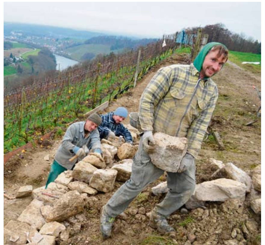
In Buchberg üben Kursteilnehmer des Schaffhauser Vogel- und Naturschutzvereins das Erstellen einer Trockenmauer. Der herrliche Blick auf den Rhein bei Eglisau ist dabei eine angenehme Nebenerscheinung.
